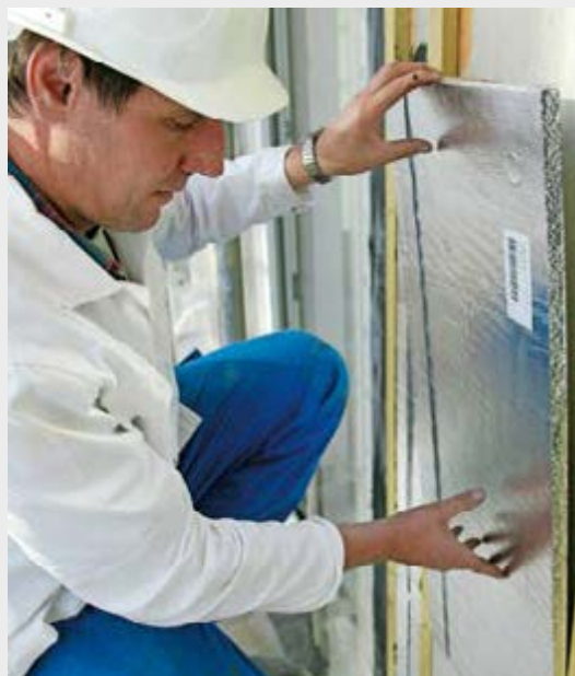
VIPs in den verschiedensten Anwendungen: In Transportboxen für Lebensmittel oder in der Gebäudedämmung in Form von Baupaneelen.
